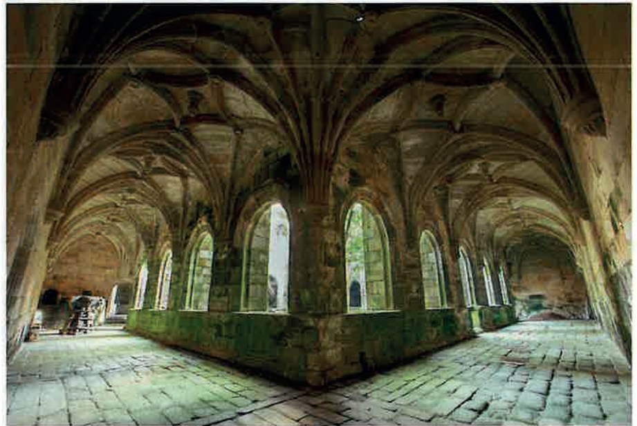
Vista del CLAUSTRO RENASCENTISTA del monasterio. La guerra de la Independencia, la expulsión de los monjes durante el Trienio Liberal y la desamortización de 1836 abocaron al edificio al abandono.
